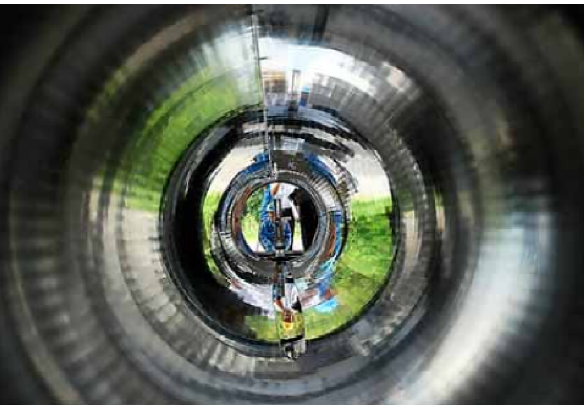
内側の表面処理を終えたパイプ＝三愛プラント工業提供
